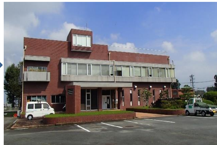
中須水道管理センター
