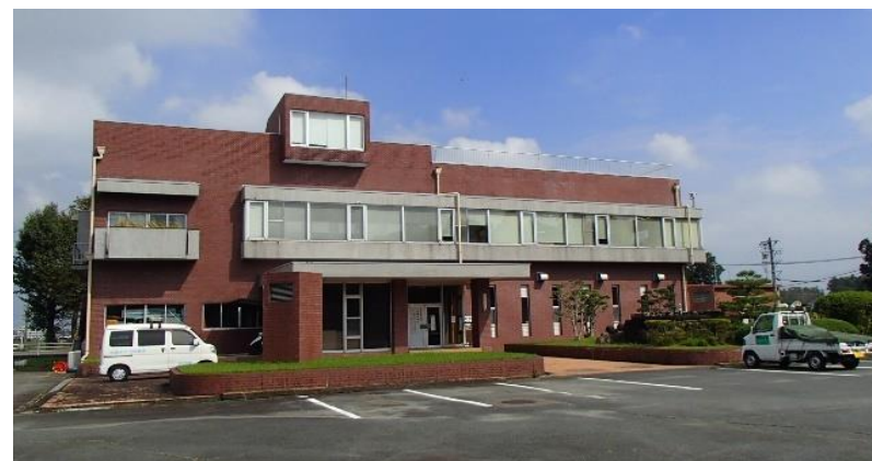
【中須水道管理センター】
